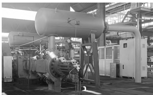
图 2 余隙无级调节系统安装现场
